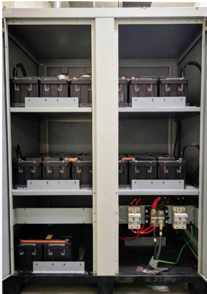
■ 汰換高壓機房不斷電系統電池。
